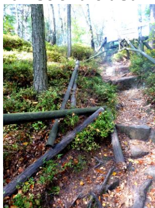
Původní stav zábradlí
