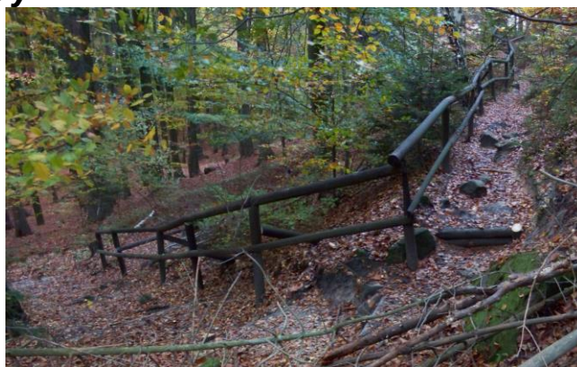
Opravené zábradlí a schody
