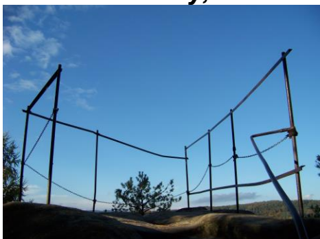
Původní stav zábradlí
