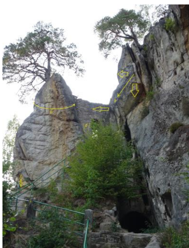
Obr.6 a) vektory sil působících na překlad branky a velký skalní blok, b) smysl předpokládaných pohybů bloků, c) prasklina indikující možnou rotaci bloku, d) praskliny u branky
