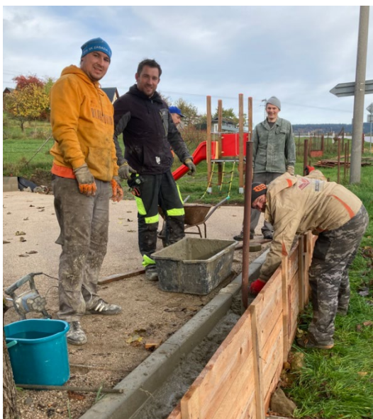
Přísné oko stavebního dozoru
